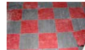
2. Revêtement de sol de type « Floor Flex »
