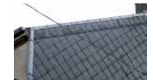
17. Bardage de façade
