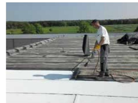
Pose de l'étanchéité sur le hall national de karaté avec l'assistance d'un expert du département Roof Consulting
